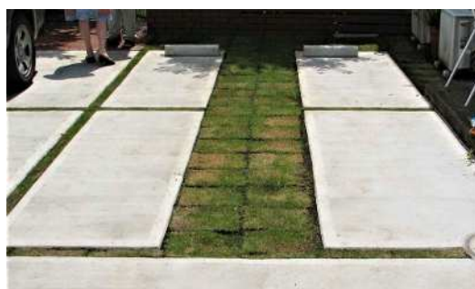
<駐車場緑化事業の施工例>
